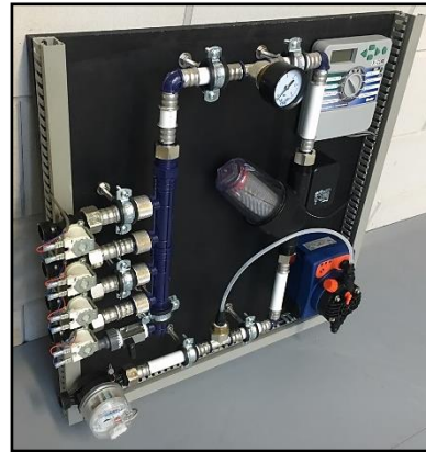
Figuur 3 Irrigatie verdeler met 4 groepen en voedingstoffenmodule
