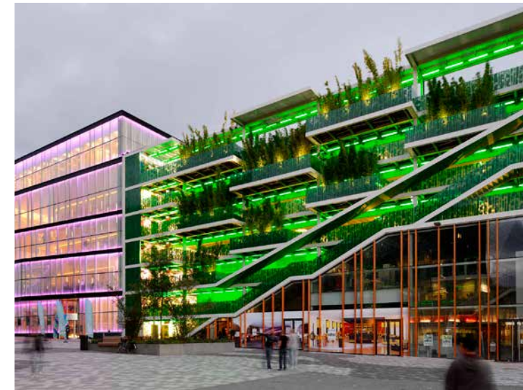
Irrigatiesysteem openbare parkeergarage te Nieuwegein
